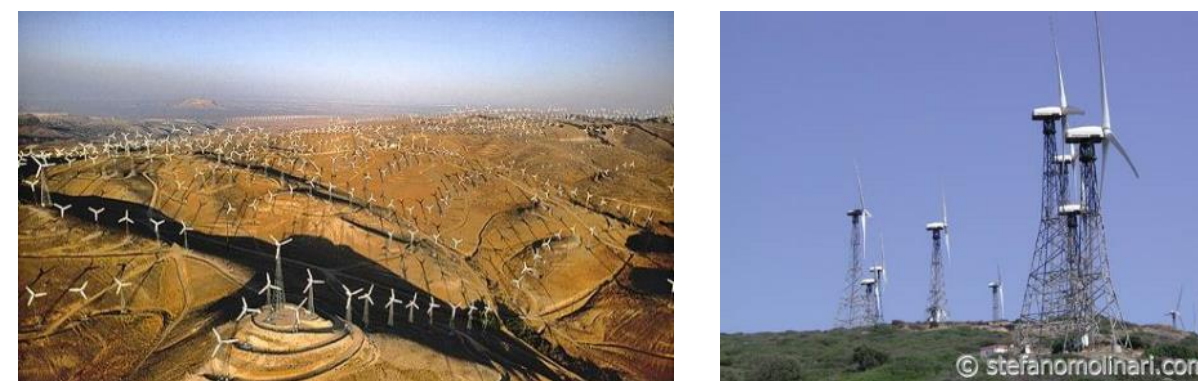
Figure 137 : Clichés des anciennes générations de parcs éoliens en treillis mortifères aux USA (Altamont Pass, Californie à gauche) ou en Espagne (Tarifa, à droite)
